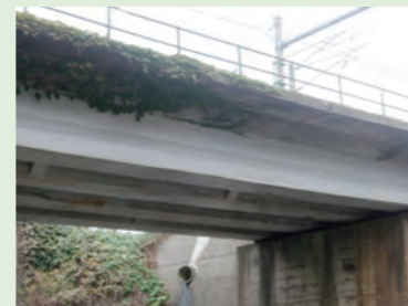
写真1 海岸沿いの橋梁の桁
