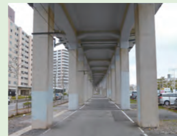
写真2 海岸に近い高架橋の橋脚
